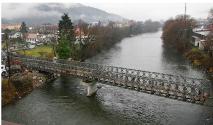
Die transportable Bailey-Brücke kann auch über größere Flüsse errichtet werden
